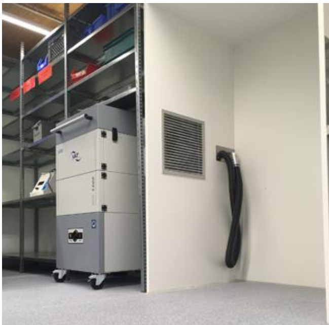
Bild 3: Absauganlage links neben der Reinigungskabine
