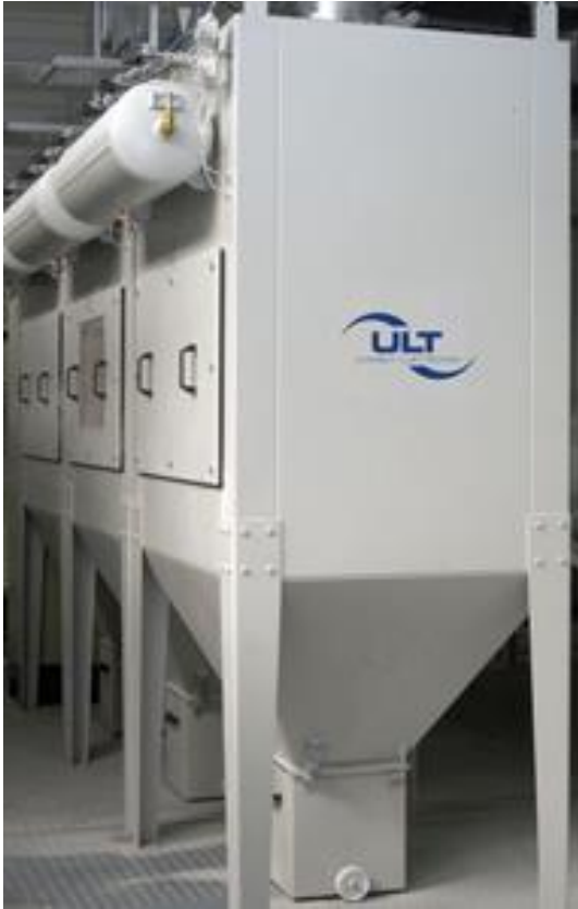
Bild 3: Kompakte Luftreinigungsanlagen der ULT AG in der GFK-Fertigung
