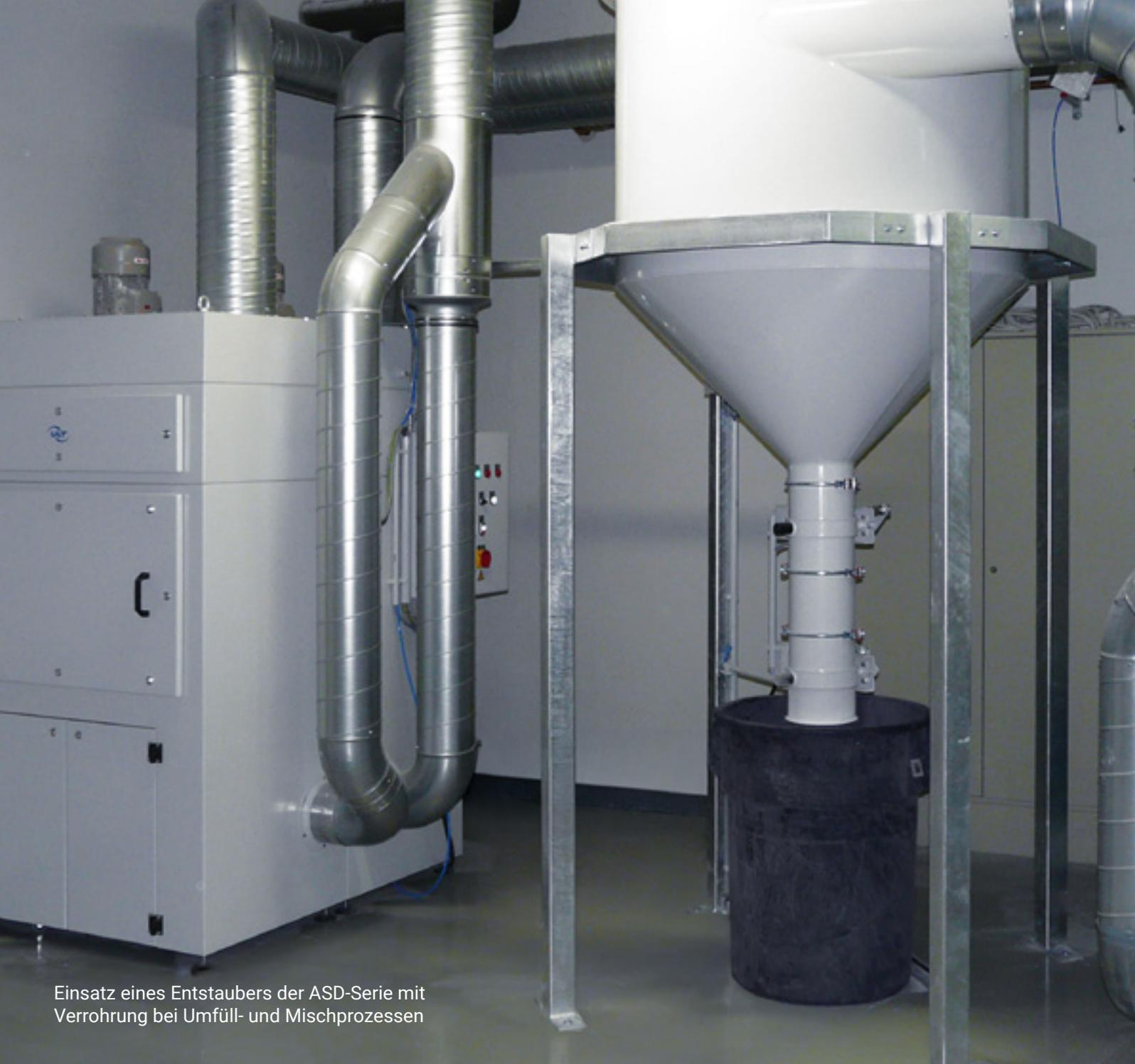
Einsatz eines Entstaubers der ASD-Serie mit Verrohrung bei Umfüll- und Mischprozessen
