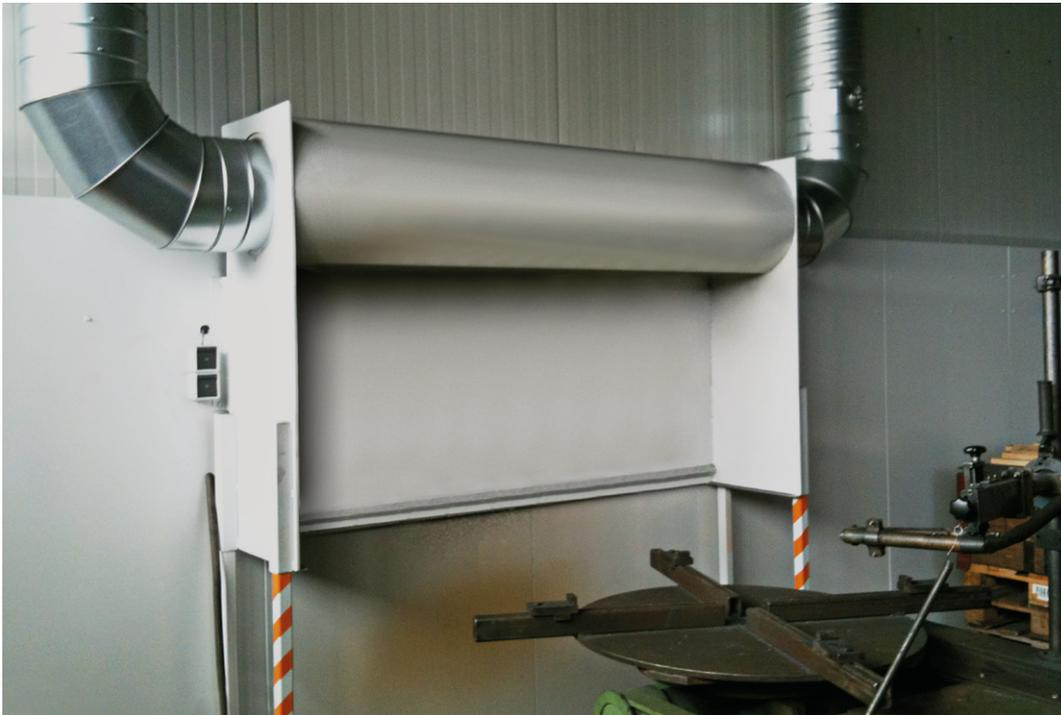
Bild A.9: Beispiel für eine Raucherfassung mittels Wirbelhaube
