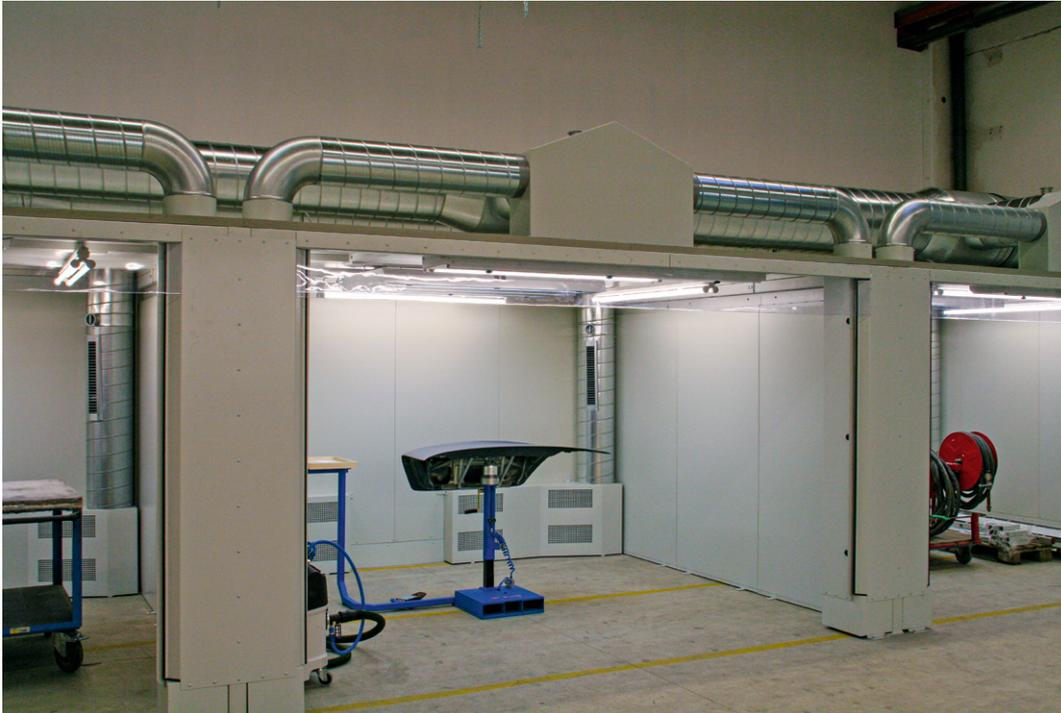
Bild A.1: Beispiel für eine Schleifkabine (halboffene Bauart) mit rückwärtiger Erfassung und Zuluftunterstützung
